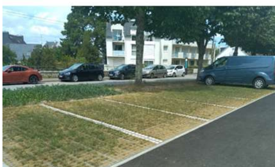
Fonction de stationnement + fonction hydraulique = parkings perméables
